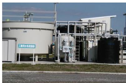
凝集沈殿装置
